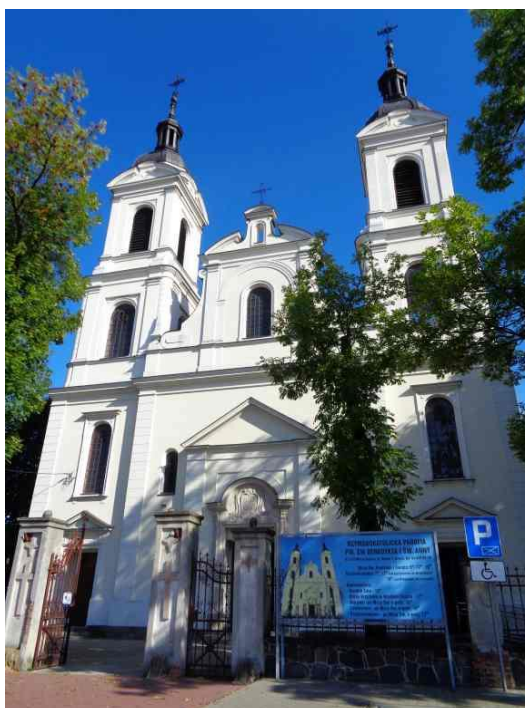
Fot. 12. Kościół w Srocku – przysłonięcie dużą tablicą informacyjną. Fot. I. Pecyna
